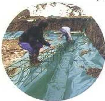
El **TERMIFILM** es el primer tratamiento de prevención contra las termitas que no contamina el suelo. El termicida, incorporado al polímero, tiene una acción a la vez **mortal y repulsiva** sobre el devastador de la madera.
